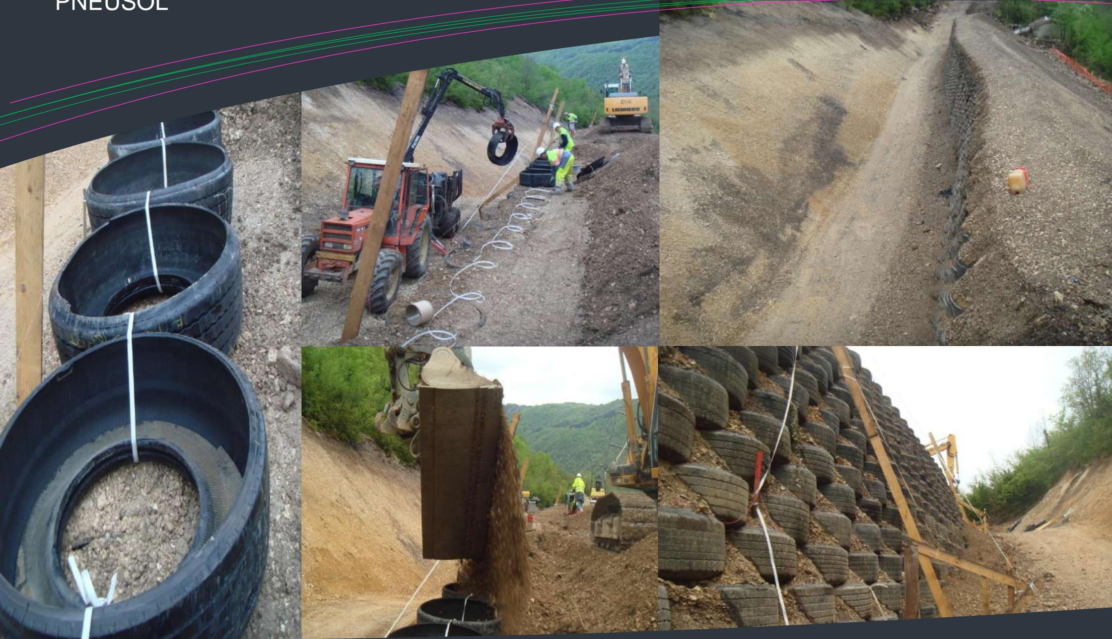
Les ouvrages construits en **Pneusol** sont donc **souples**, capables de supporter sans dommage des **tassements différentiels importants**. Cette technique offre une **bonne répartition des efforts** dans la masse du matériau et sur fondations. La végétation recouvre l'ouvrage rapidement.
